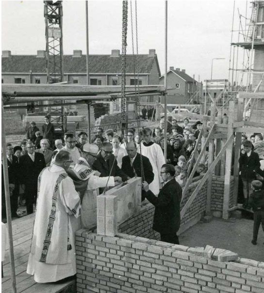
11 oktober 1964 eerstesteenlegging H. Geest door pastoor Brandenburg. Foto: archief BHC
